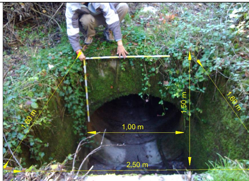
Sezione di monte dell'attraversamento (tombotto)
